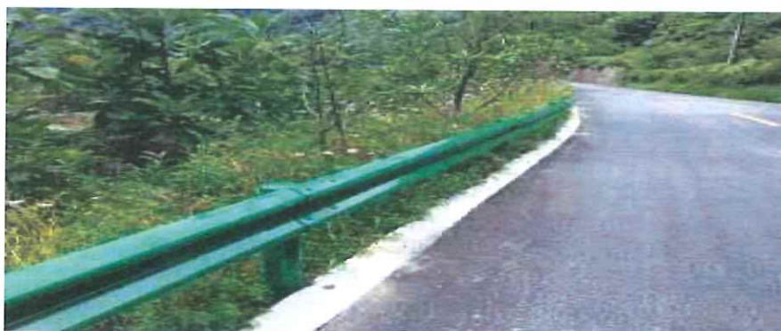
图 24、 饮用水源保护防撞护栏结构示意图和样图
